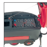
Machine ouverte avec batteries
