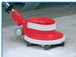
Meuler du béton/coulis de ciment
